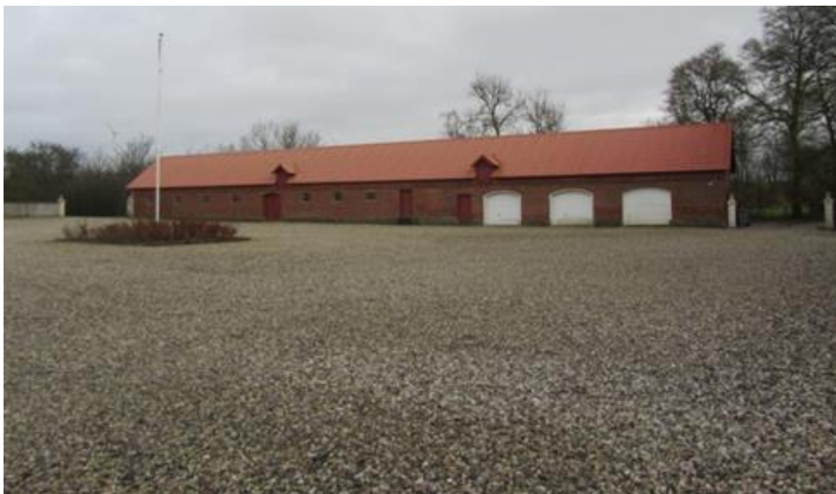
Tidligere hestestald. Nu bilgarager og lager. Udbygning 3
